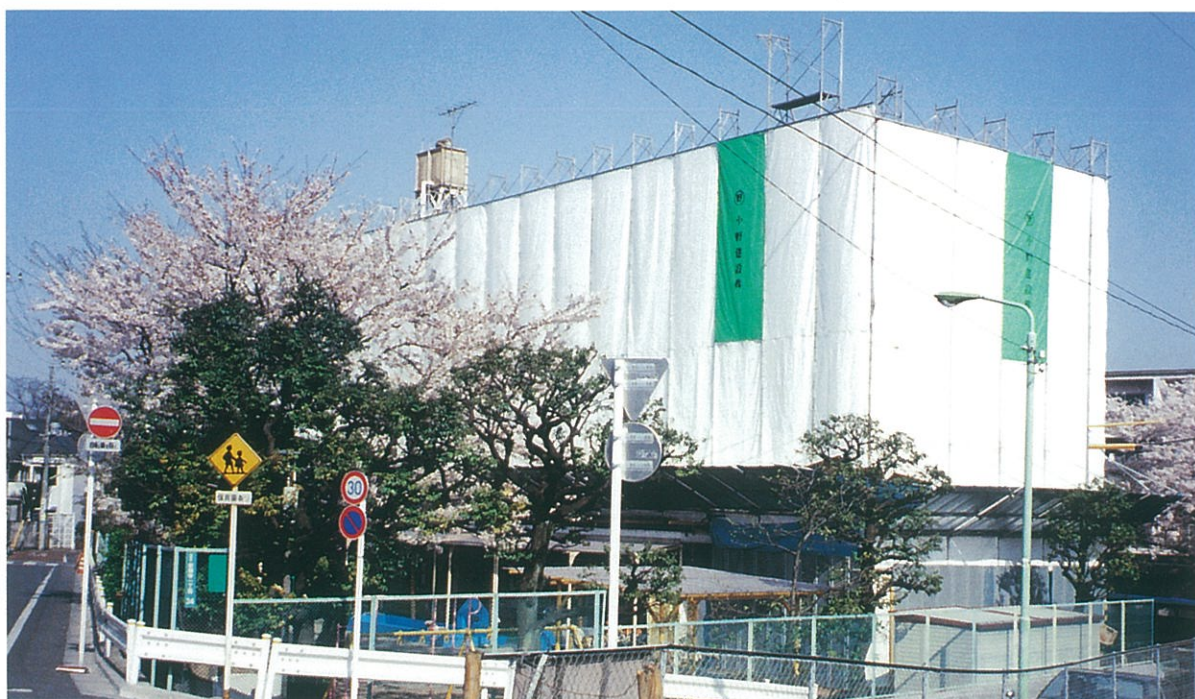
都営住宅04M-5708建(豪徳寺母子アパート)工事
