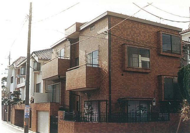
エリア柿木坂新築工事
